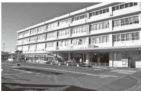
▲ 早期整備が望まれる国府津駅広場
