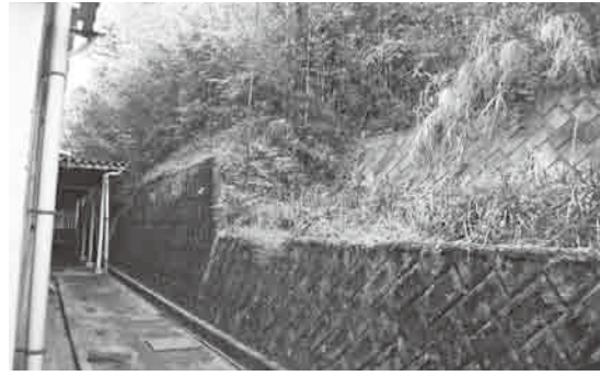
▲ 整備される城南中学校北側のり面
